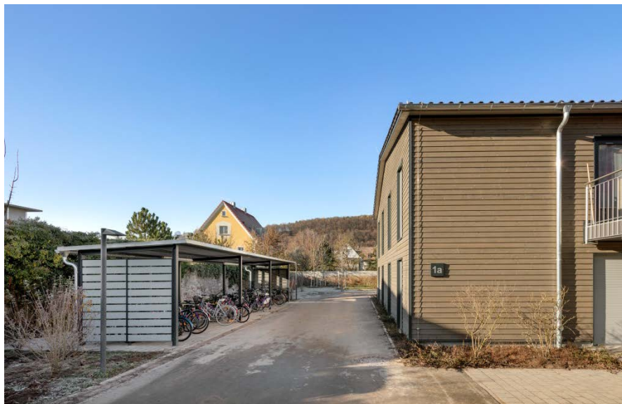
Eingang in die Wohnanlage (© Gerhard Hagen, Bamberg)
